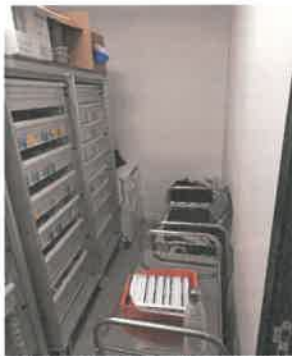
Photo 2 : Place de travail à infirmerie - M. Boudinet - Sept. 2024
